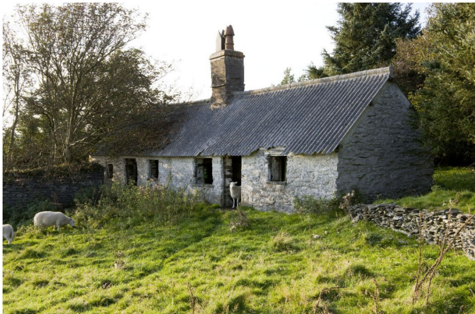
Bwlch Du -September 2008- Coflein
